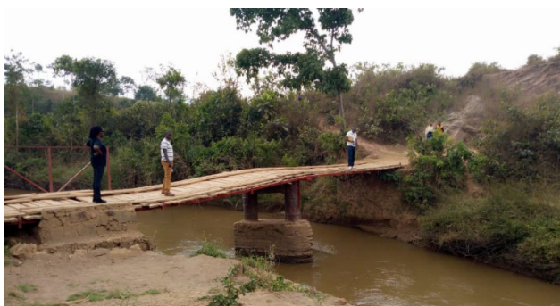
Photo: Pont reliant Makamba et la Commune de Kibago
